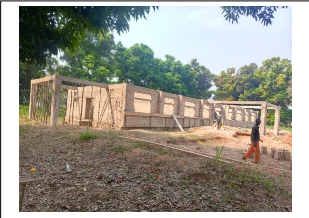
Bâtiment Administratif de Territoire de Dimbelenge en construction
